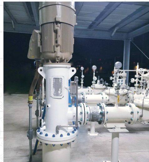
TRANSFERÊNCIA DE COMBUSTÍVEL DE AVIAÇÃO
